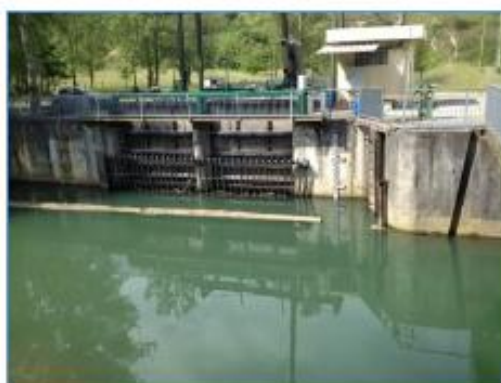
La prise d'eau du Peyrat
