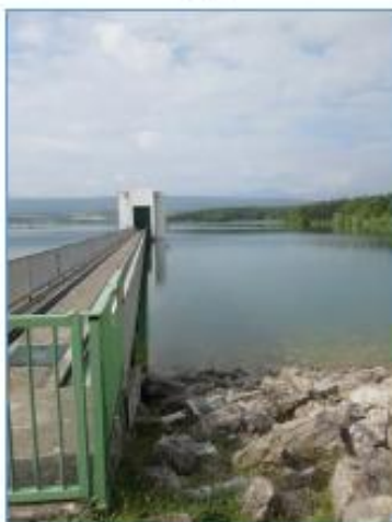
Barrage de Montbel
