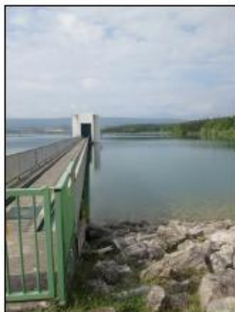
Barrage de Montbel
