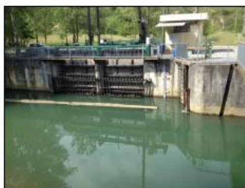
La prise d'eau du Peyrat
