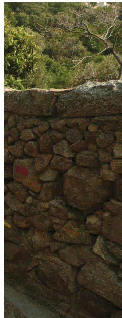
Exemples de couronnement de grande dalles posées à plat en débord bilatéral
