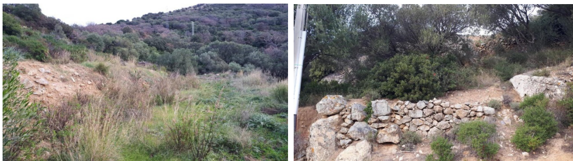
Plateforme existante Petit patrimoine dégradé
