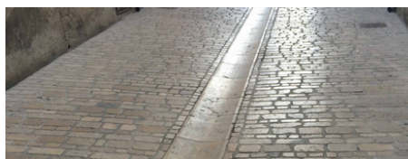
Revêtement voie mixte
