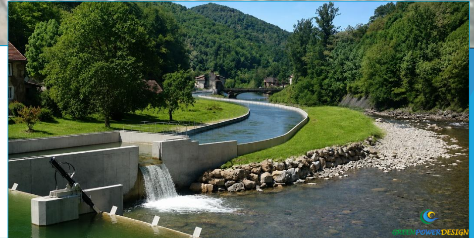
Canal en éléments préfabriqués sur le Salat
