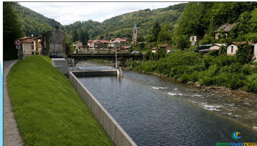
Chambre d'eau d'un groupe DIVE sur le Salat
