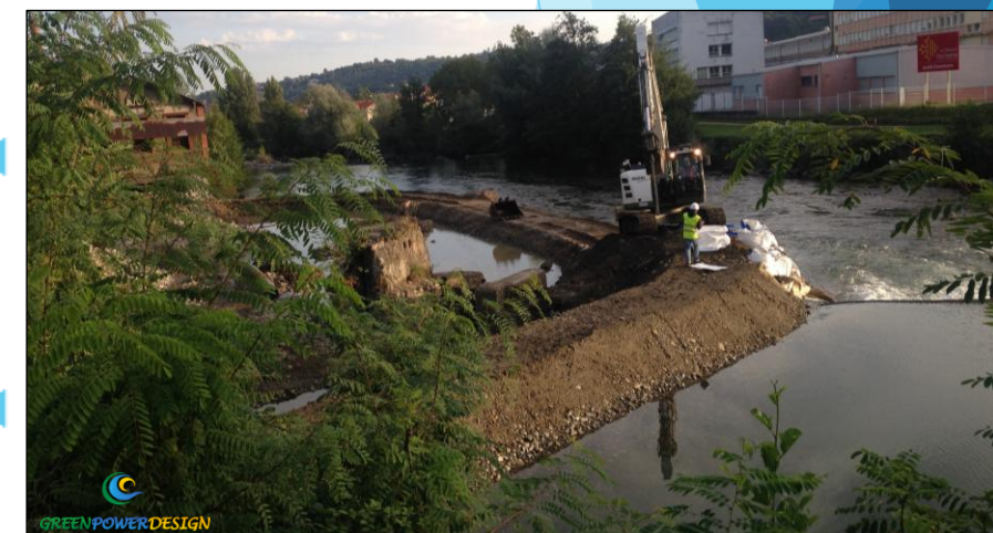
Batardeau en cours de réalisation sur le Salat
