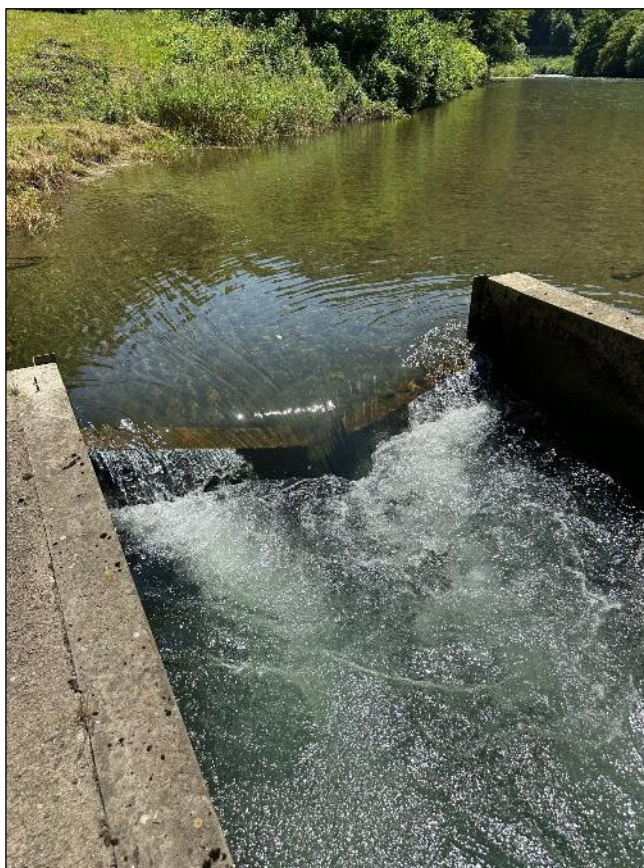
Figure 14 : Exemple de passe mixte à échancrures triangulaires sur le Salat (Etudes et maîtrise d'œuvre Green Power Design)
