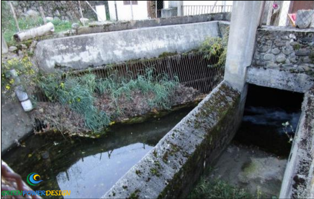
Figure 8 : Vue du plan de grille depuis l'amont
