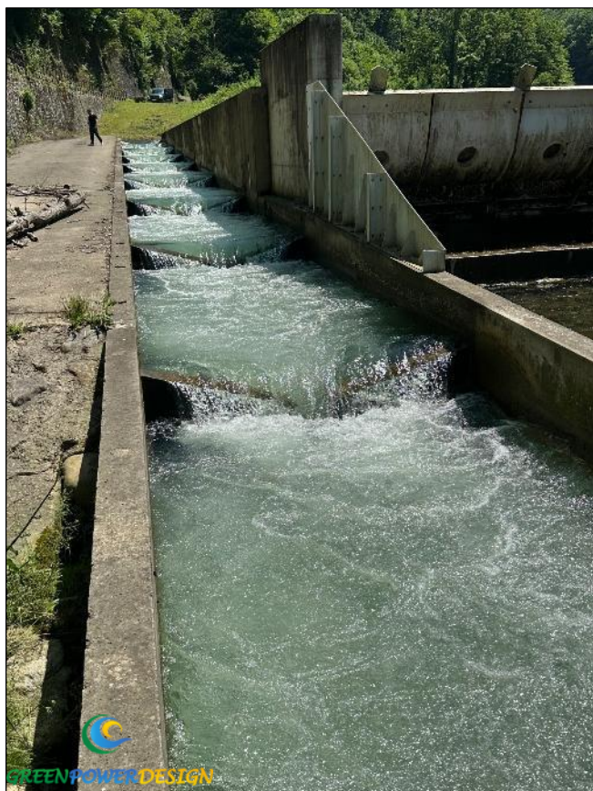
Figure 14 : Exemple de passe mixte à échancrures triangulaires sur le Salat (Etudes et maîtrise d'œuvre Green Power Design)
