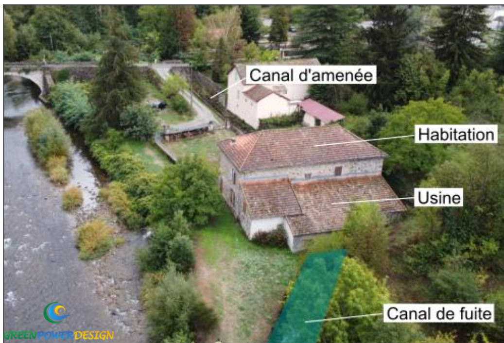
Figure 9 : Vue du bâtiment d'usine depuis l'aval
