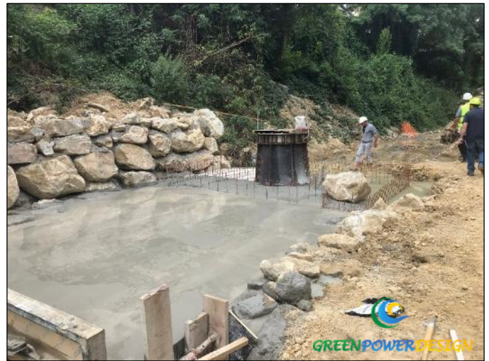
Figure 29 : Exemple de pose et de coulage d'aspirateurs de turbine DIVE La Louge (31) - Etudes et maîtrise d'œuvre Green Power Design
