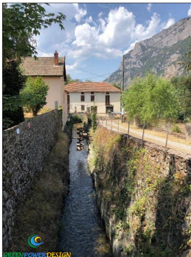
Figure 7 : Vue de la partie aval du canal
