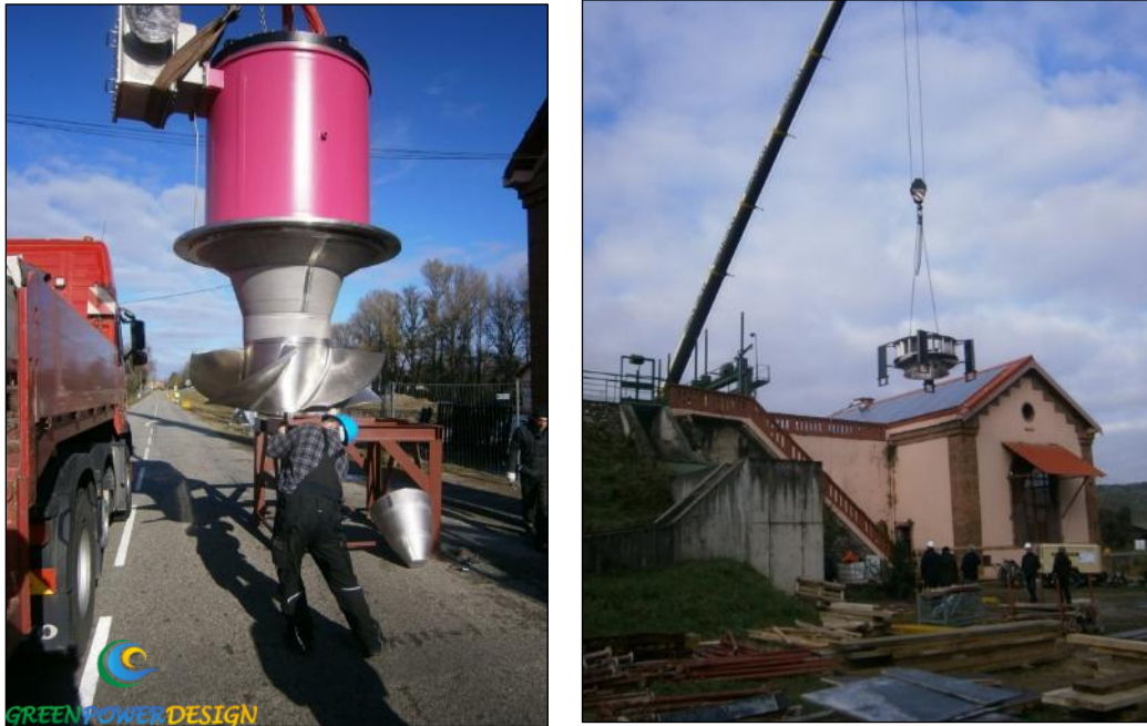
Figure 31 : Pose d'une turbine DIVE
