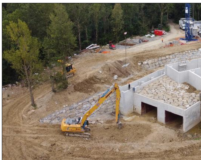
Figure 22 : Exemple d'enrochement bétonné réalisé sur une rampe de restitution (Ariège à Grépiac / Etudes et maîtrise d'œuvre Green Power Design)
