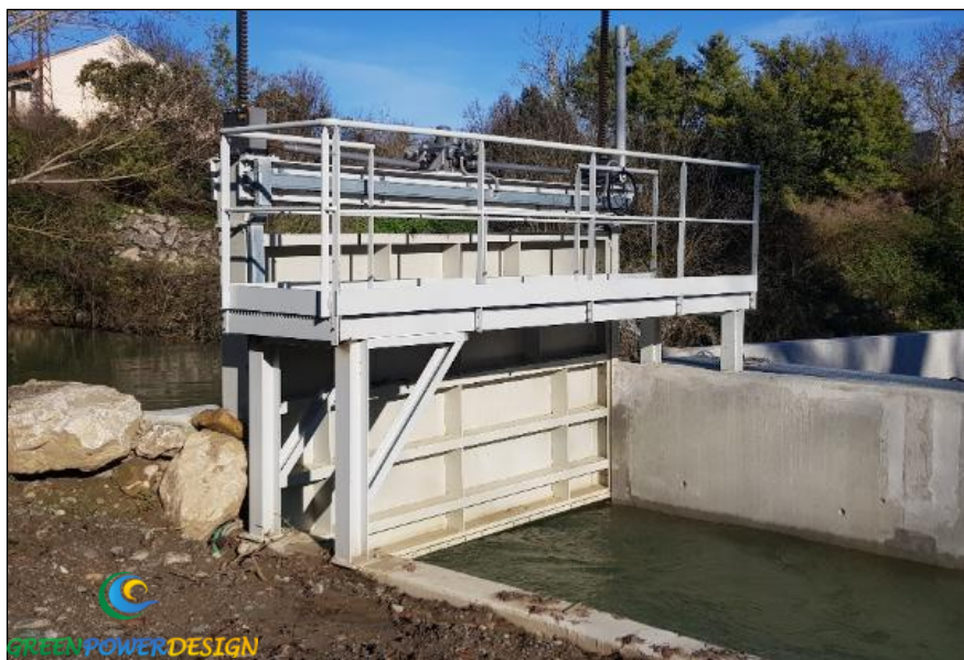
Figure 15 : Exemple de vannage de prise d'eau sur la Louge (Etudes et maîtrise d'œuvre Green Power Design)
