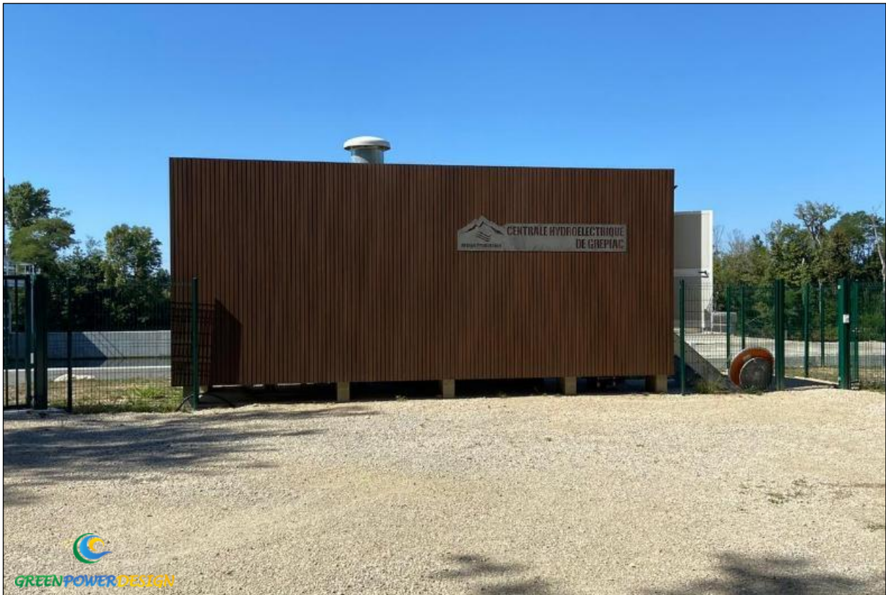
Figure 20 : Exemple de local d'usine associé à un groupe de production immergé (Ariège à Grépiac / Etudes et maîtrise d'œuvre Green Power Design)
