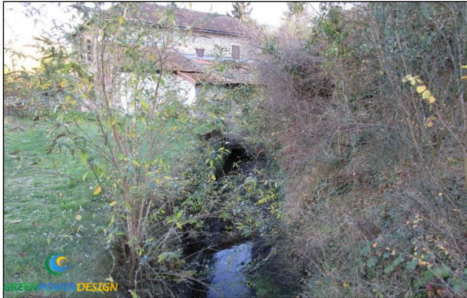
Figure 10 : Vue du canal de fuite depuis l'aval
