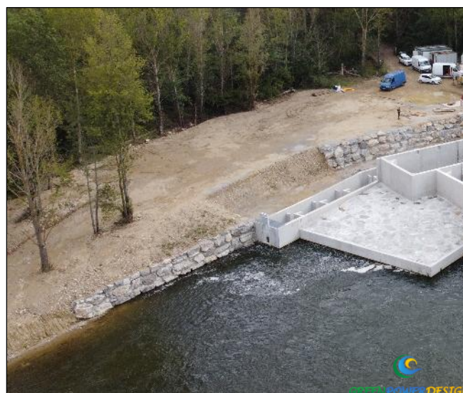
Figure 22 : Exemple d'enrochement bétonné réalisé sur une rampe de restitution (Ariège à Grépiac / Etudes et maîtrise d'œuvre Green Power Design)
