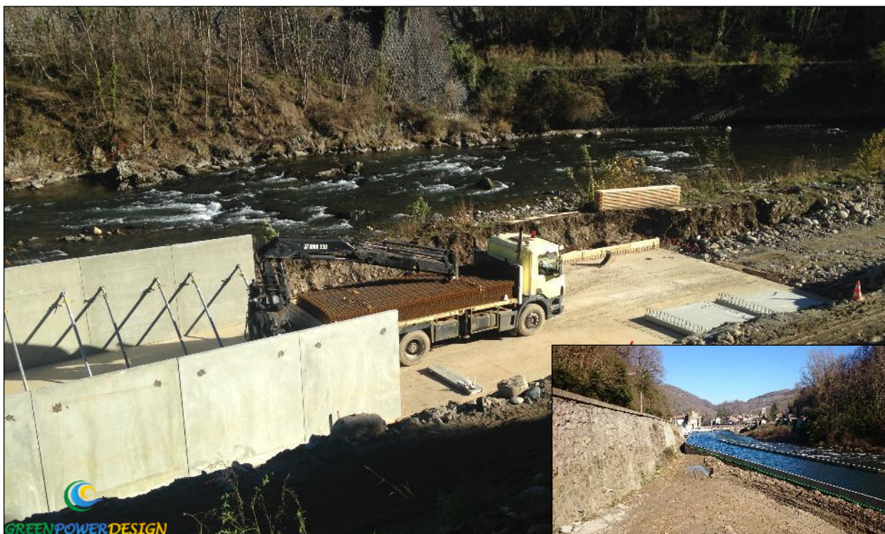
Figure 37 : Exemple de canal d'amenée en construction en dérivation du Salat selon la méthode constructive envisagée (Etudes et maîtrise d'œuvre Green Power Design)
