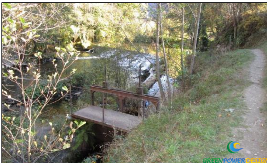
Figure 5 : Vue du vannage de prise d'eau depuis la rive gauche
