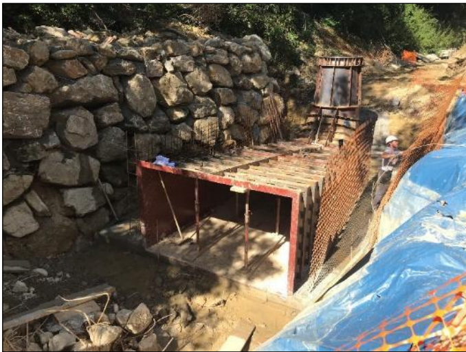
Figure 29 : Exemple de pose et de coulage d'aspirateurs de turbine DIVE La Louge (31) - Etudes et maîtrise d'œuvre Green Power Design
