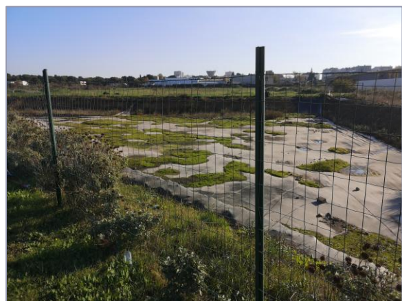
Bassin de rétention
