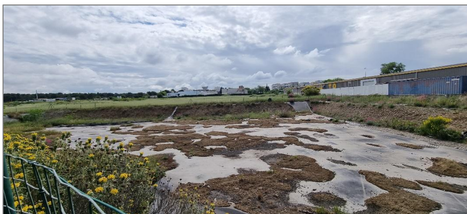
Bassin de rétention
