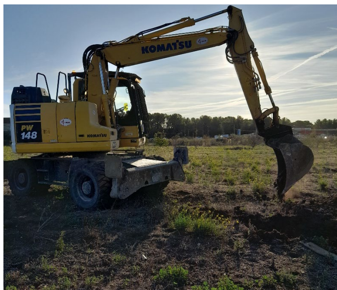
Figure 15 : Pelle mécanique utilisée pour la réalisation des fouilles en octobre 2023
