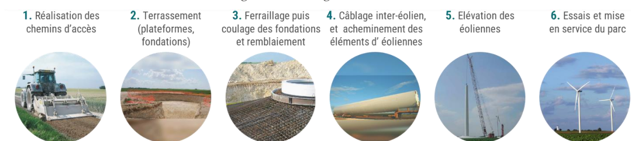
Figure 1 : Phasage des travaux
