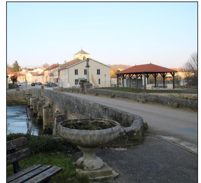
Photo 53 : Le pont sur la Saulx (MH n°53) de Rupt-aux-Nonains (Source : BE JC)
