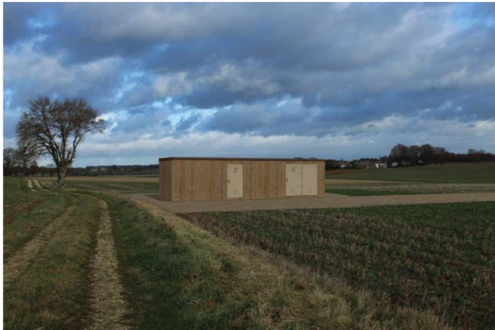
Exemple d'intégration paysagère du poste de livraison par un bardage bois
