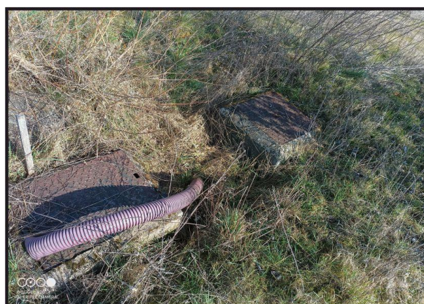
Photographie 9 : Vue sur les deux regards à l'est du site
