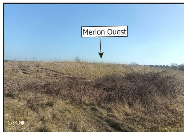
Photographie 6 : Vue sur le merlon à l'ouest
