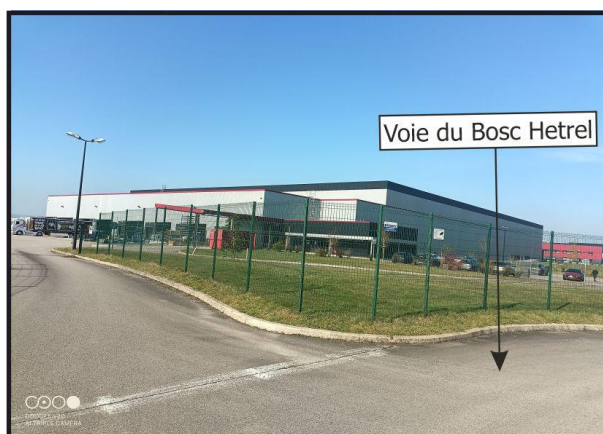
Photographie 13 : Vue sur le bâtiment à usage professionnel au nord du site
