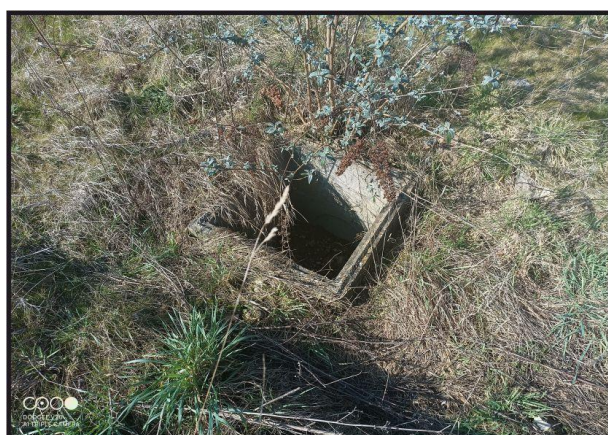
Photographie 8 : Vue sur le regard au centre du site
