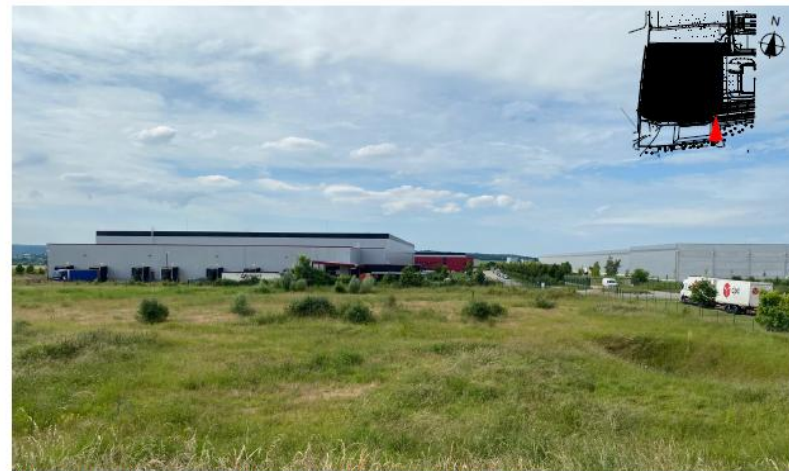
Vue n°02 : Vue du site depuis l'angle Sud-est (sur plan PC2b)
