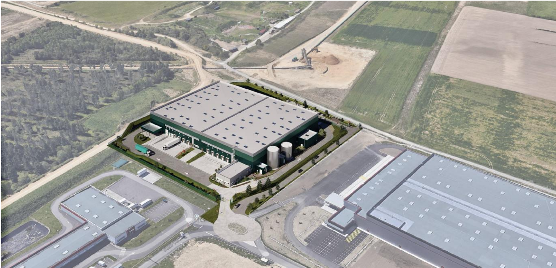
Figure 71 : Vue aérienne générale (Source : Permis de Construire)
