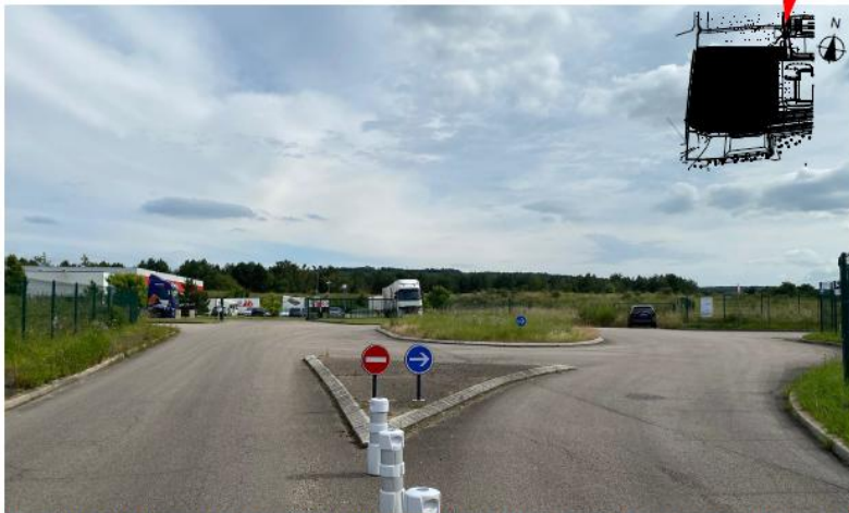
Vue n°01 : Vue du site depuis la Voie du Bosc Hétreil vers l'accès Nord principal (sur plan PC2b)
