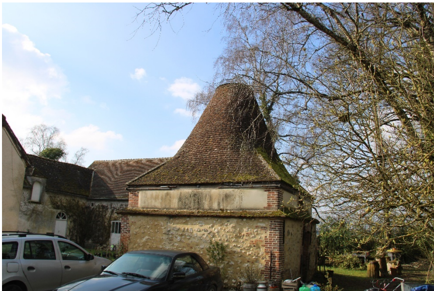
Photo 58 : L'ancienne tuilerie à Broyes (n°15) - T&P 2024
