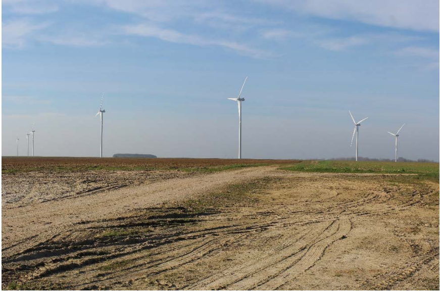
Photo 7 : Le parc éolien des Bouchats depuis Thaas - T&P 2024
