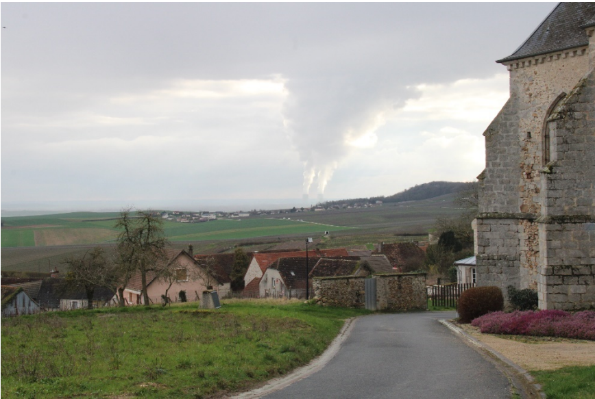
Photo 88 : Panache de vapeur de la centrale nucléaire de Nogent-sur-Seine depuis Bethon - T&P 2024
