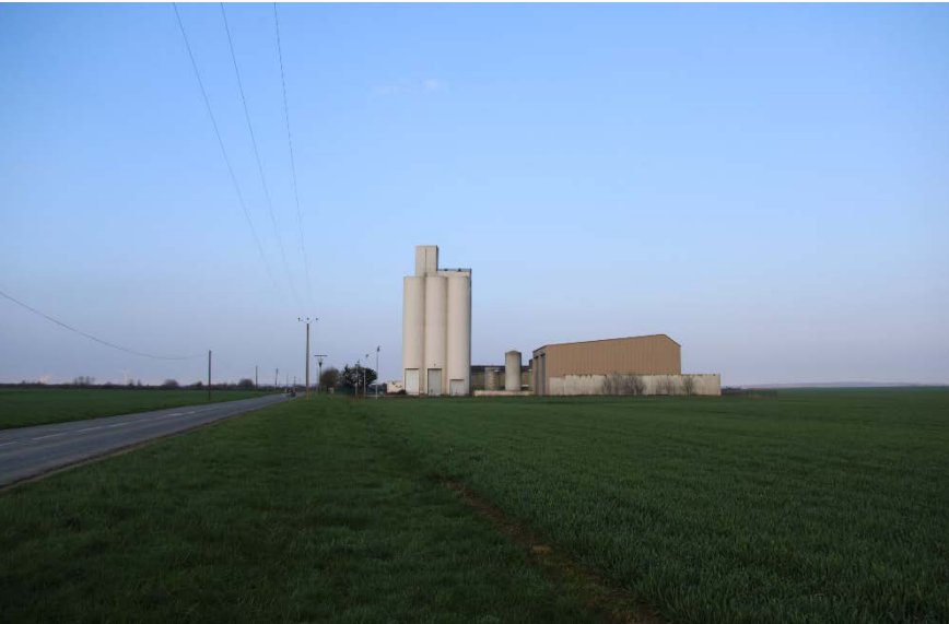
Photo 85 : Silo à l'entrée de Marigny - T&P 2024
