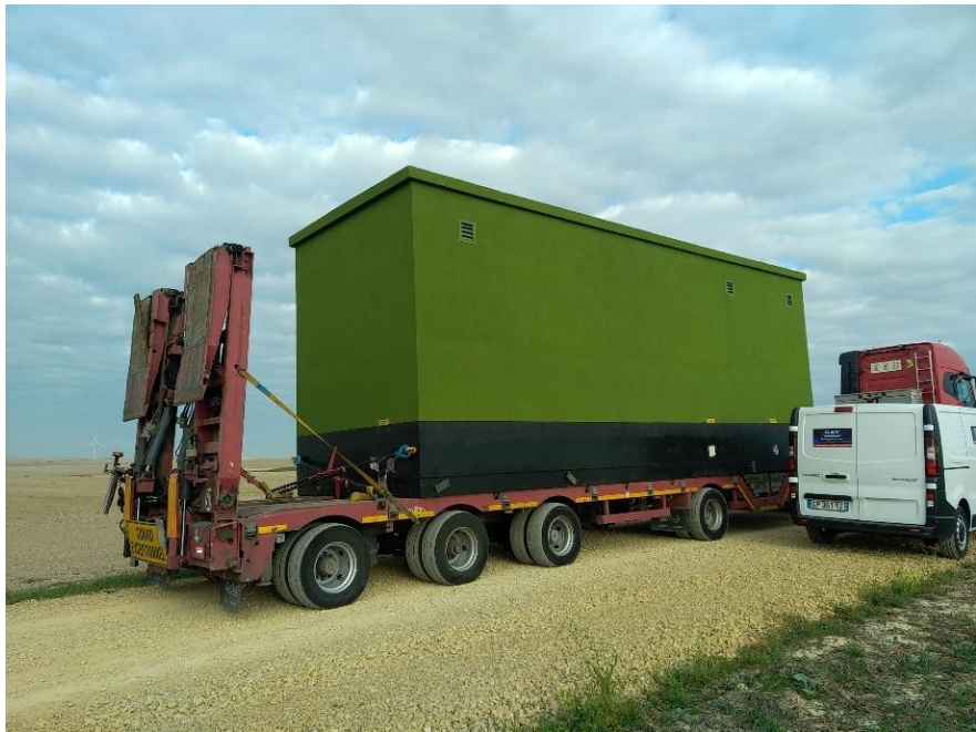
Illustration 15 : Arrivée d'un poste de livraison sur un site éolien
