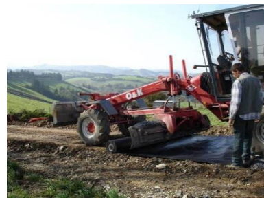
Illustration 24 : Pose du géotextile
