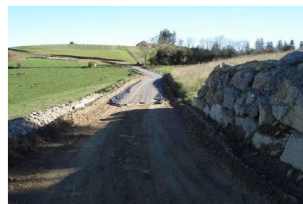
Illustration 25 : Mise en place du gravier
