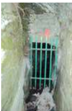
Grille - Entrée de la galerie
