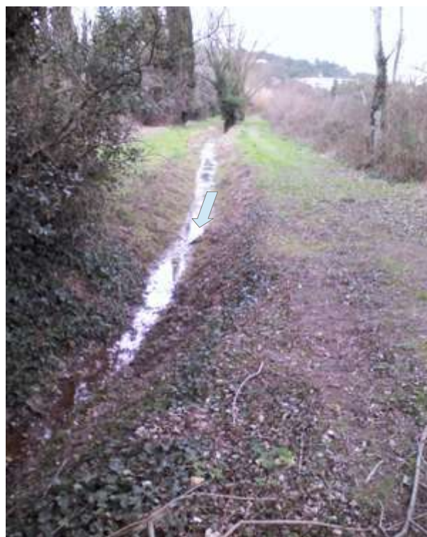
Fossé drainant la cuvette de l'Étang
