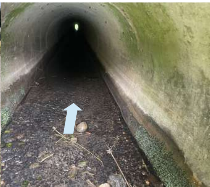
Vue du passage de la Mayre de la Mine sous A7
