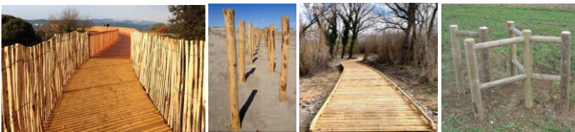
Figure 57. Exemples de cheminements et platelages bois avec cantonnement par ganivelle et pieux battus, et chicane en rondin (source : La Compagnie des forestiers / menuiserie Bertin).
