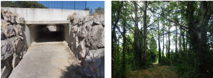
Figure 36. Ouvrage d'art et îlot boisé
