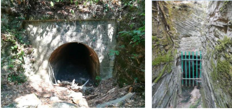
Figure 35. Galeries souterraines présentes sur la zone d'étude
