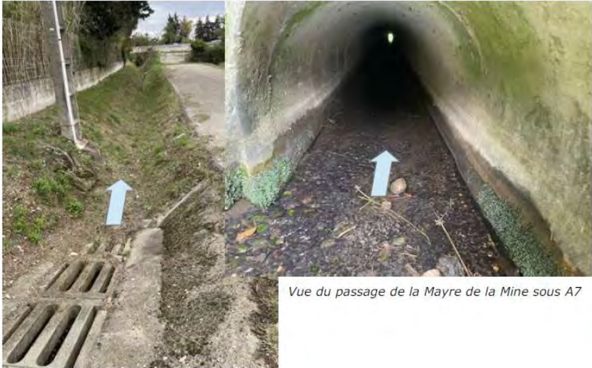
Vue de la Mayre de la Mine en amont de l'A7
