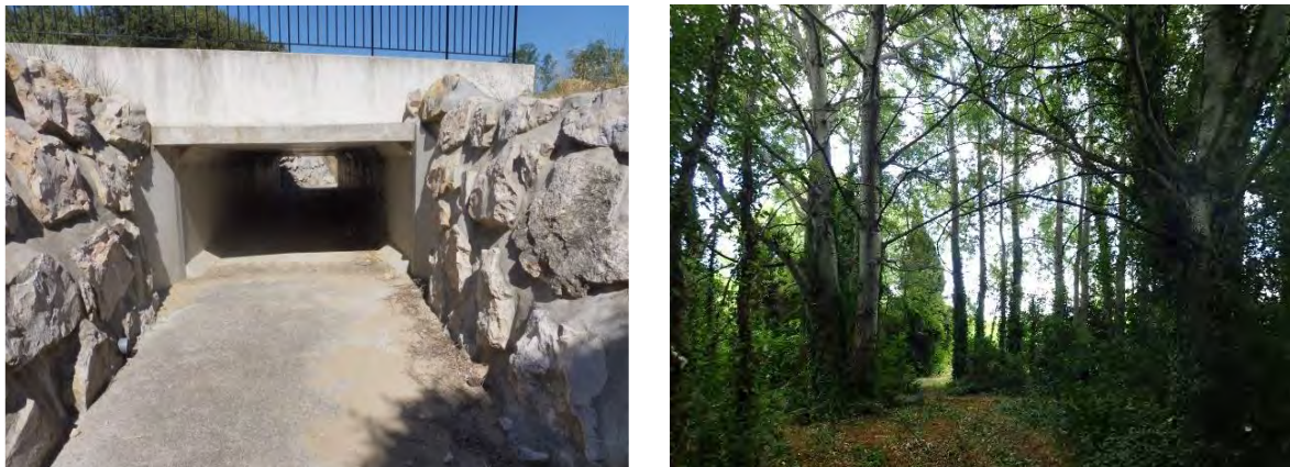
Figure 36. Ouvrage d'art et îlot boisé
