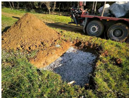
Mise en place de l'horizon 1 : première couche de gravier/sable
