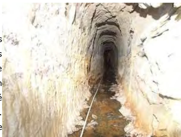
Vue de la galerie sur les premiers mètres
