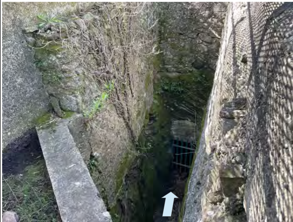
Photo N° 7 Vue du canal de la Mine (exutoire par ré-essuyage de la carrière)
