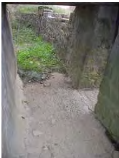
Ouverture de la martelière du Lampourdier après l'ouvrage
