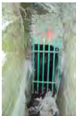
Grille - Entrée de la galerie
