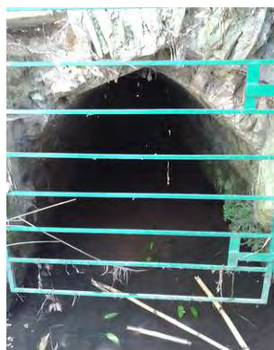
Grille - Sortie de la Galerie
