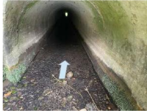
Vue du passage de la Mayre de la Mine sous A7
