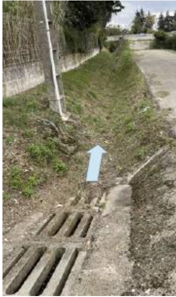
Vue de la Mayre de la Mine en amont de l'A7
