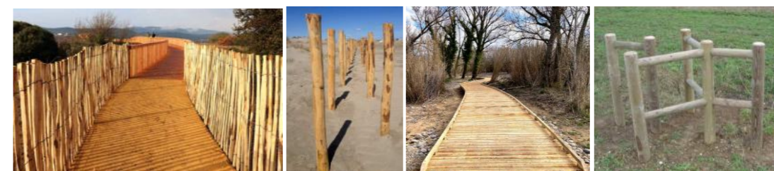
Exemples de cheminements et platelages bois avec cantonnement par ganivelle et pieux battus, et chicane en rondin (source : La Compagnie des forestiers / menuiserie Bertin).
