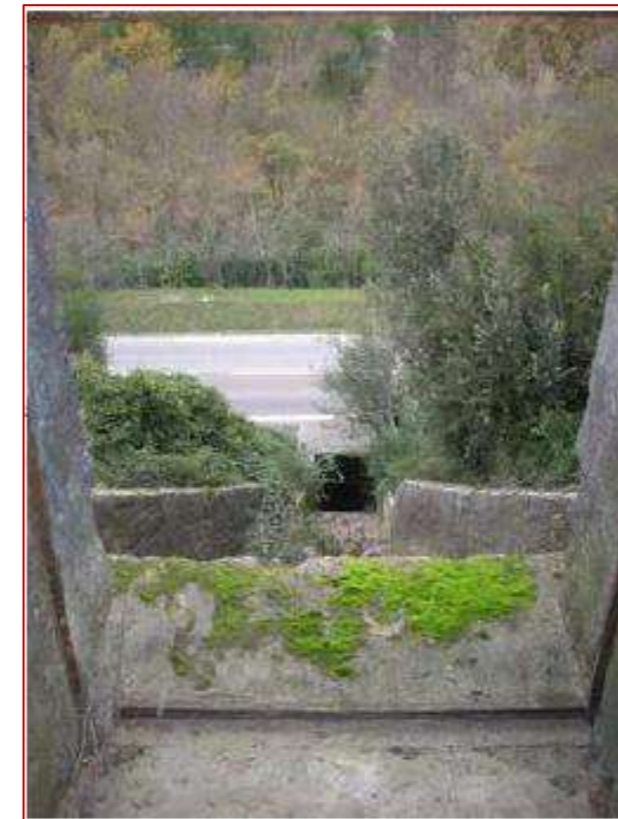
Figure 28 : Rejet du Lampourdier - Exutoire vers la Meyne
