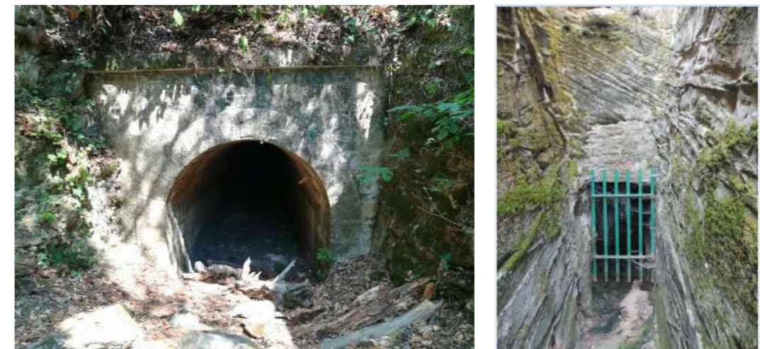
Figure 119 : Galeries souterraines présentes sur la zone d'étude
