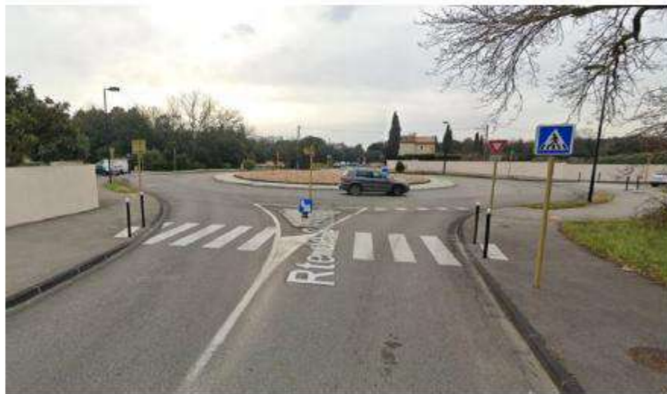
Giratoire D68 – Chemin de Venissat Nord – av H. de Noix de St Marc : une géométrie assurant une circulation fluide et sécurisée
