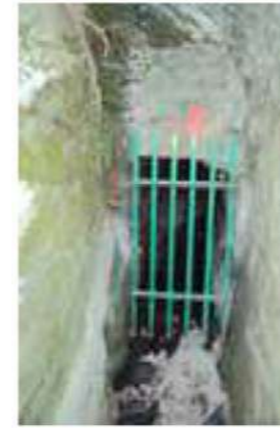
Grille - Entrée de la galerie
