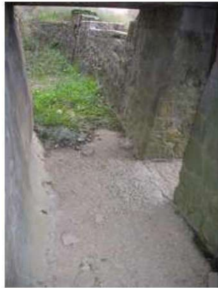
Ouverture de la martelière du Lampourdier
