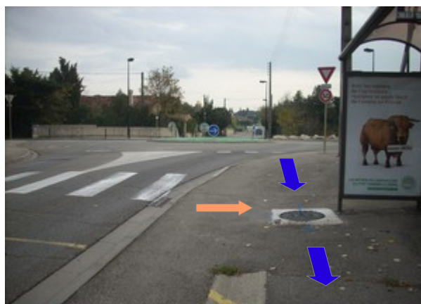
Arrivée du réseau ER48a sur la branche Sud en 700 mm
