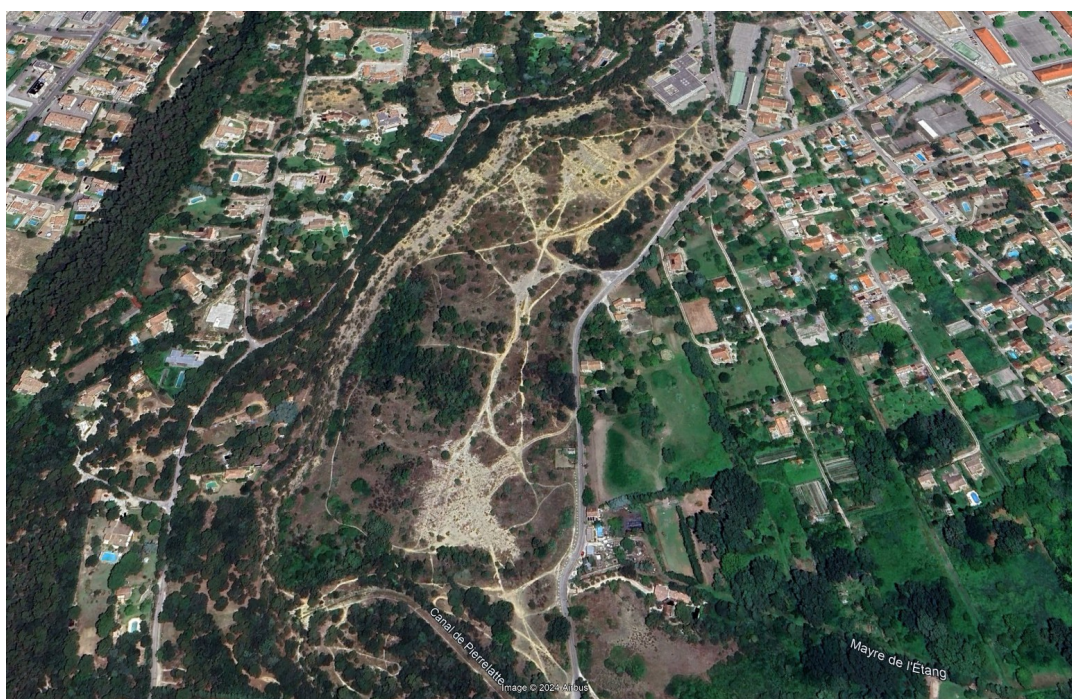
Vue aérienne de la localisation du projet – ancienne carrière de la colline St Eutrope
