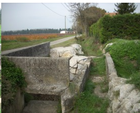
Ouvrage (chemin des Fours à chaux)
