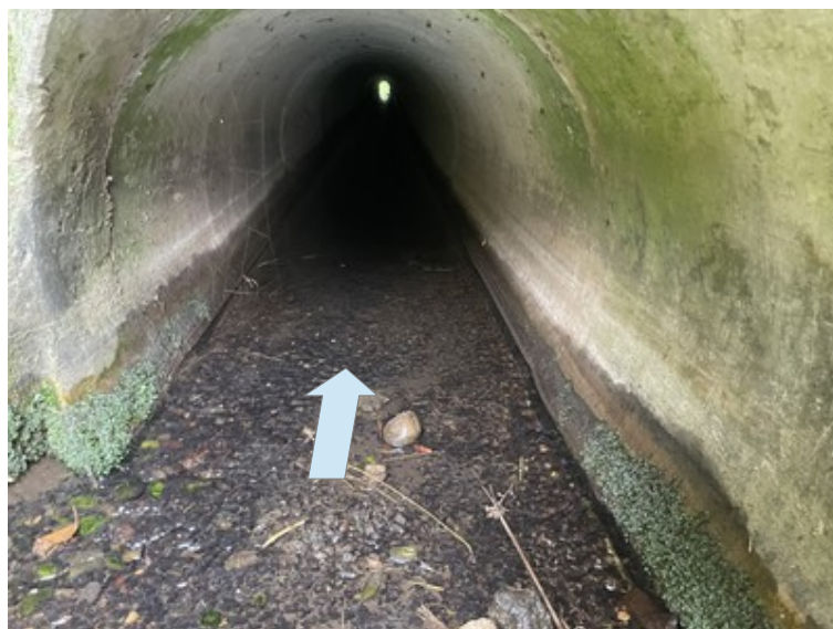
Vue du passage de la Mayre de la Mine sous A7
