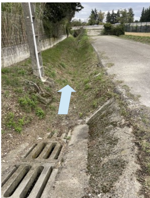
Vue de la Mayre de la Mine en amont de l'A7
