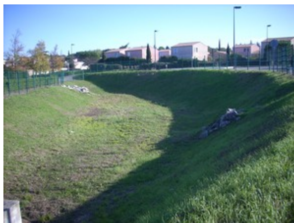
Vue du bassin de rétention au niveau du carrefour Albin Durand / RD68
