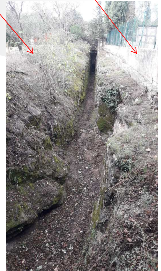
Vue vers l'aval
