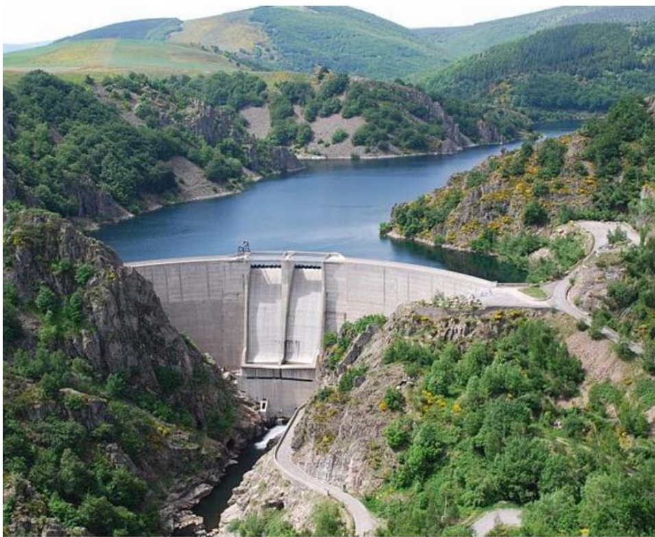
Le barrage de Puylarent et sa retenue sur la rivière du Chassezac (Département de Lozère - 48)
