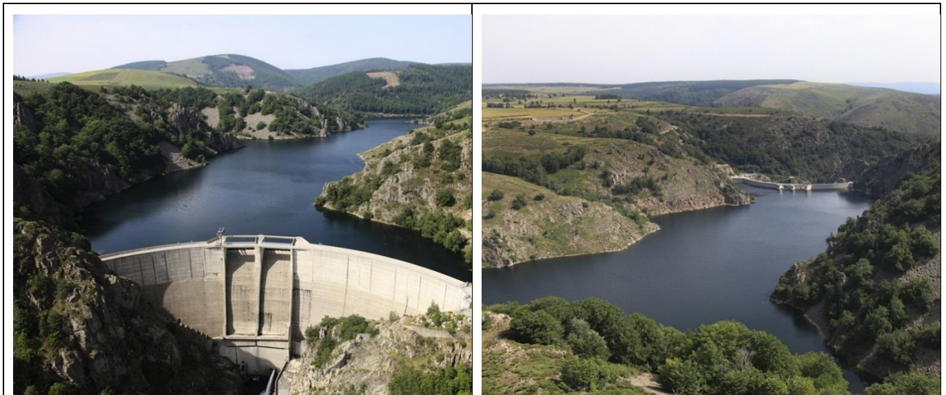
Figure 30 : Barrage (à g) et retenue (à dr) de Puylaurent (Source : EDF-CFBR)
