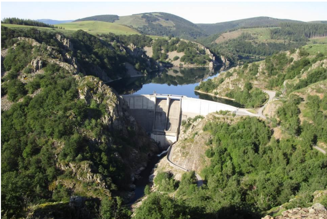
Figure 3 : Vue d'ensemble du barrage de Puylaurent et de sa retenue depuis le belvédère (juin 2019)
