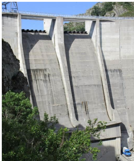
Figure 4 : Evacuateur de crues du barrage – vue depuis l'aval (juin 2019)
