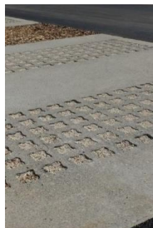
Béton alvéolaire avec un remplissage gravillonné
