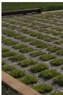
Béton alvéolaire avec un remplissage végétalisé
