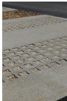
Béton alvéolaire avec un remplissage gravillonné
