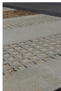
Béton alvéolaire avec un remplissage gravillonné
