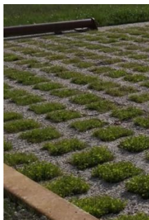
Béton alvéolaire avec un remplissage végétalisé
