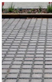
Pavés à joints élargis avec un remplissage gravillonné
