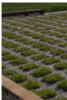
Béton alvéolaire avec un remplissage végétalisé
