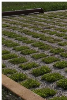
Béton alvéolaire avec un remplissage végétalisé
