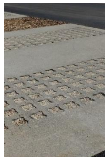
Béton alvéolaire avec un remplissage gravillonné
