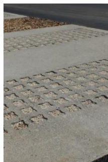
Béton alvéolaire avec un remplissage gravillonné
