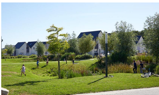
Bassin de récupération des eaux pluviales végétalisé, Fontenay
