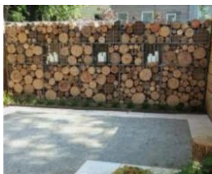
Mur en gabion en bois parfait pour l'accueil des insectes
