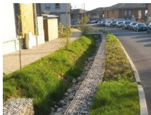
Tranchée drainante, Plaine et coteaux de la Seine centrale urbaine
