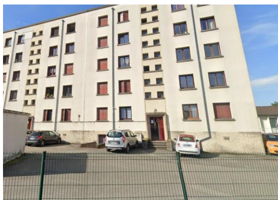
Stationnement imperméable en pied d'immeuble Rue Charles Rivoire, Villard-Bonnot X
