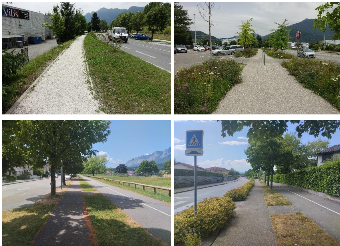
Aménagement chemin piéton. Albertville (73), Crolles (38)
