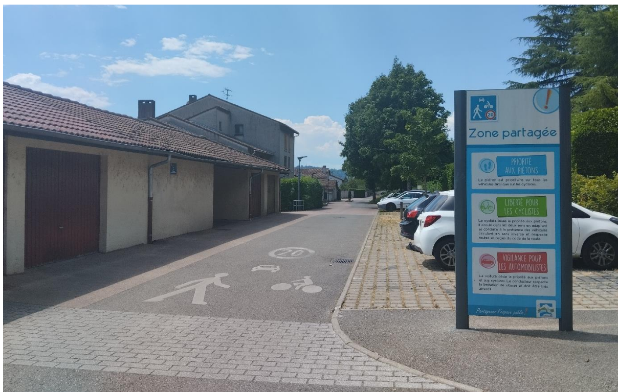
Exemple d'aménagement zone de rencontre Crolles (38)
