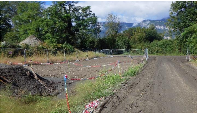
3 – Vue transversale vers l'Isère depuis la zone
