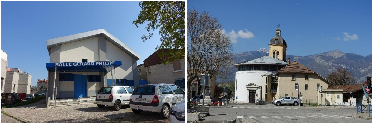
Des parvis devant les édifices religieux et publics comme ici devant la Salle Gérard Philipe et l'Eglise dédié au stationnement et à la circulation
