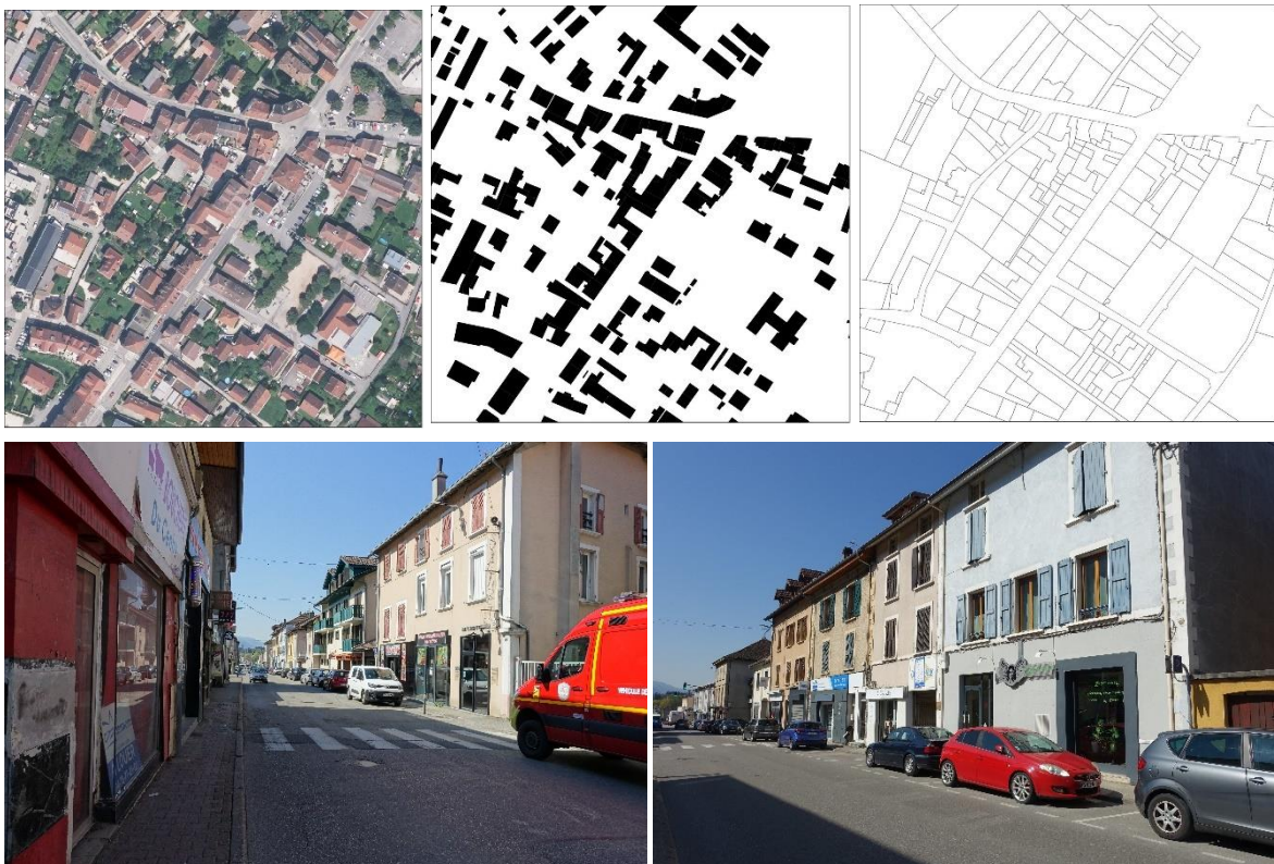
Brignoud : Un tissu bâti qui s'organise autour d'une voie centrale et qui laisse place à la déambulation piétonne.
