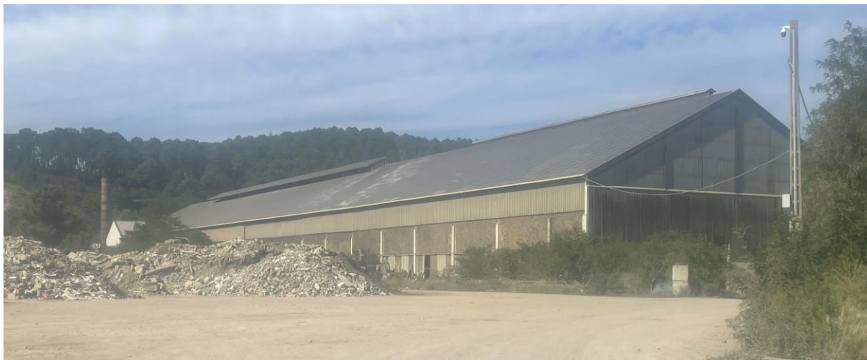
Photographie du bâtiment du site de BOUDON & FILS
