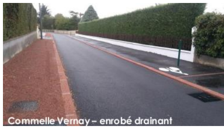
Commelle Vernay – enrobé drainant Source : Roannaise
