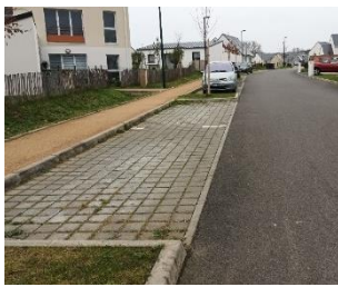
Parking perméable Source : GMVA
