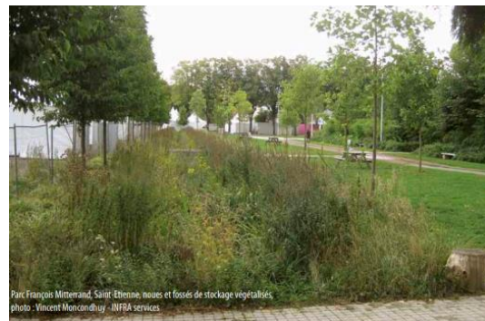
Source : Infraserivices Noue plantée en arbustives et arborées
