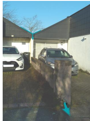
Lotissement "Les hameaux de Cliscouët", Morbihan Habitat, Vannes, Descentes de gouttières et gargouilles dans un muret
