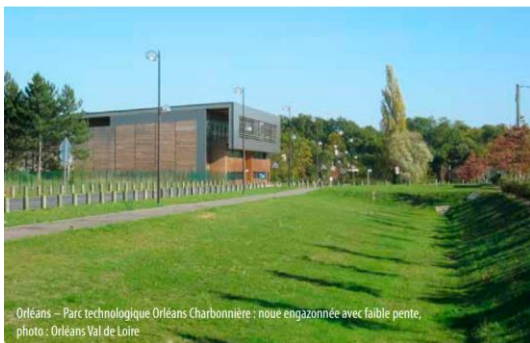
Source : Orléans Val de Loire Noue plantée en herbacées
