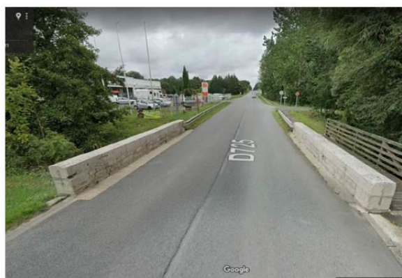
Figure 1 : Passage au niveau de la Fontpoise (Source : Google, septembre 2021)
