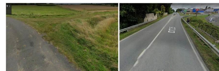
Figure 2 : Passage au niveau de la Fontenelle (à gauche) et de l'Oure (à droite) (Source : Google, 2021)
