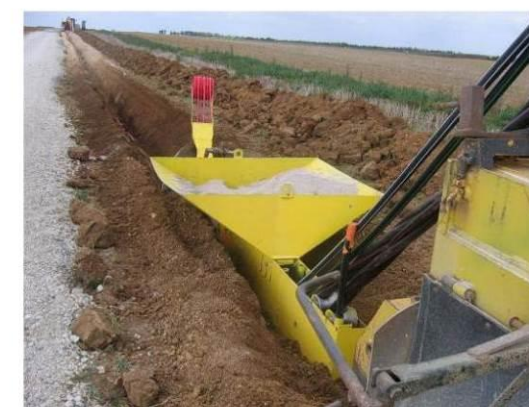
Figure 6 : Prise de vue d'une dépose de câble à l'aide d'une trancheuse
