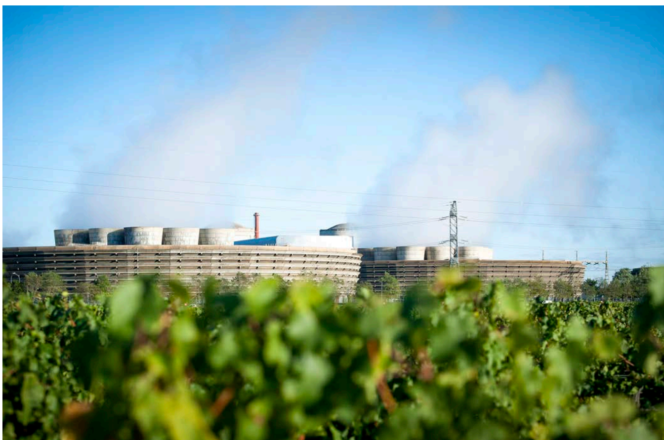
Centre Nucléaire de Production d'Électricité de Chinon.
