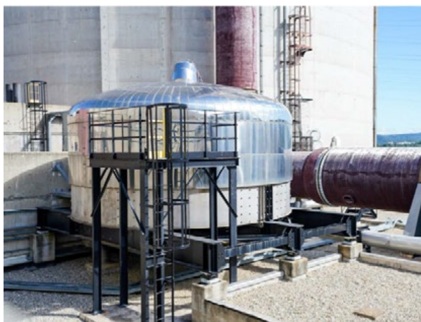
Figure 15. Photo du dispositif d'évantage et de filtration de l'enceinte (filtre U5)
