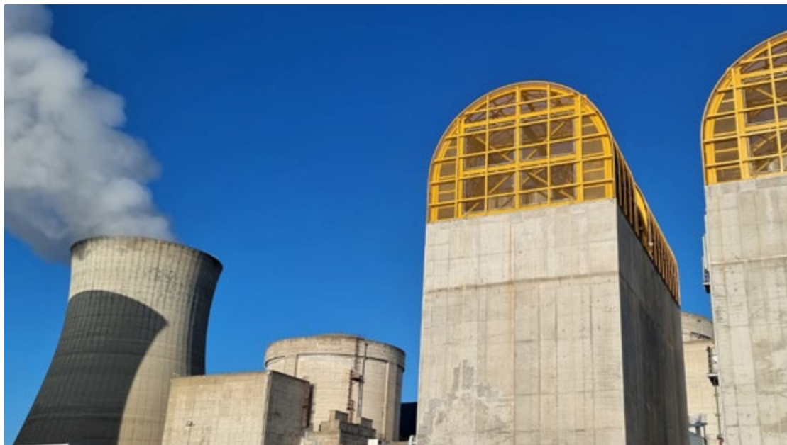
Diesels d'ultimes secours (DUS) des réacteurs n°3 et n°4
