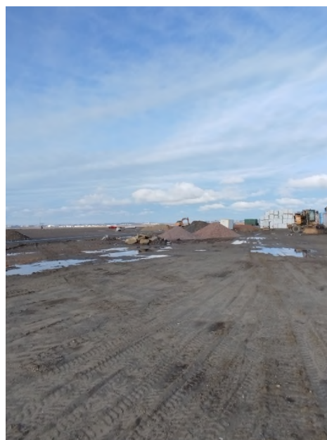
Stockage de matériaux au Nord du site
