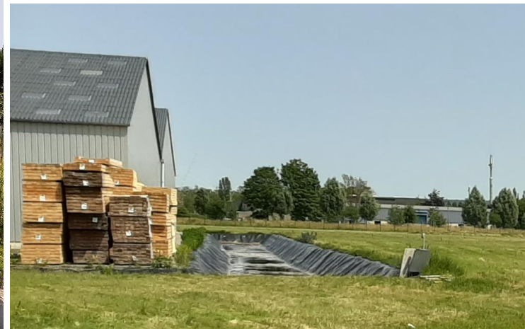
Fossés étanches présents en périphérie d'installations
