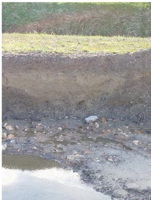
Lithologie au droit du site (au niveau du bassin en construction)
