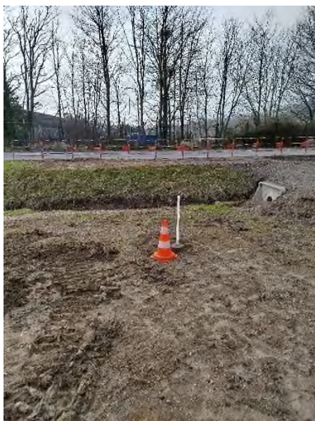
Pose de PzR1
