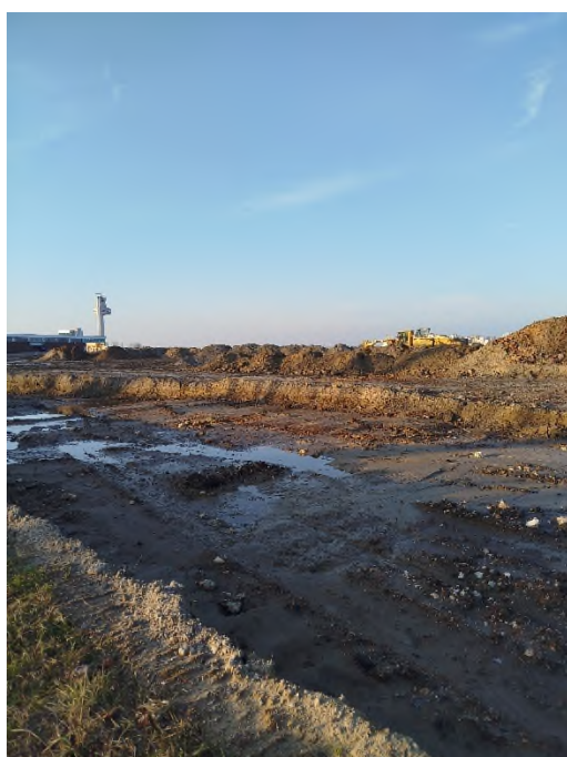
Bassin en construction au Sud du site
