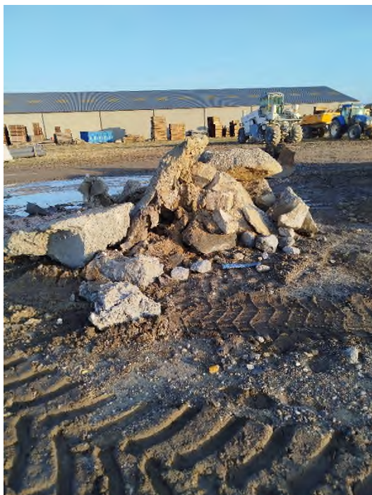
Déchets stockés sur le site (1/2)
