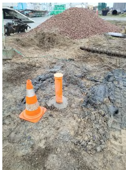
Cimentation de PZ3
