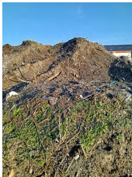
Matériaux stockés sur le site (2/2)
