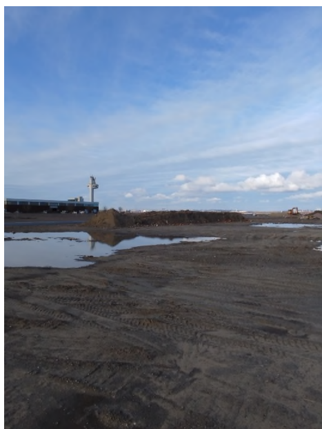
Stockage de matériaux à la limite Est du site
