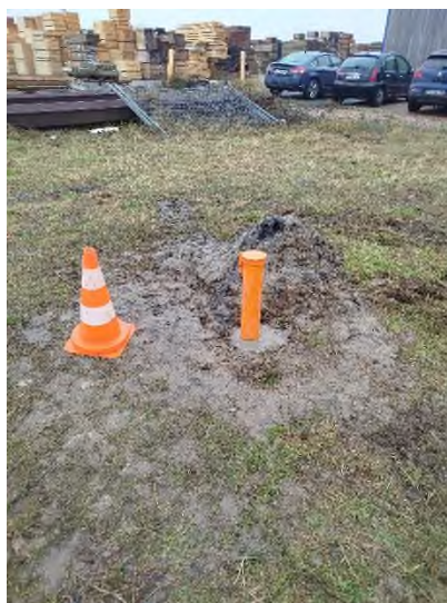
Cimentation de PZ2
