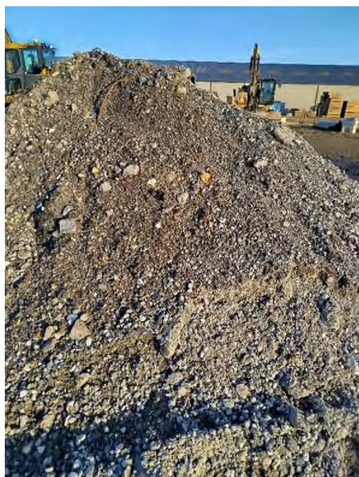
Matériaux stockés sur le site (1/2)
