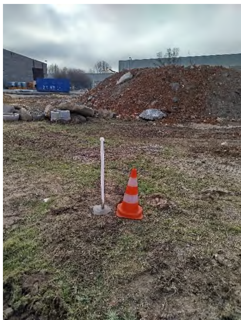
Pose de PzR2
