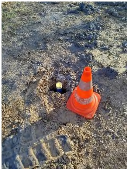
Pose de PZ1
