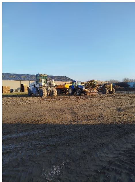
Stockage d'engins au Nord du site
