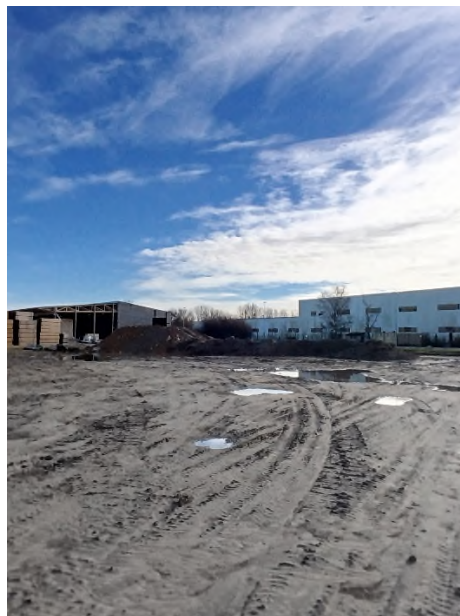
Stockage de matériaux au Sud Est du site
