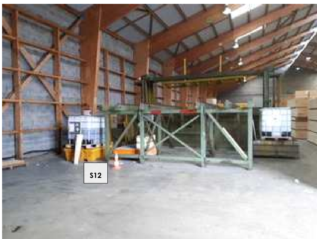
Sondage S12 (bâtiment 2 – cuve trempage)
