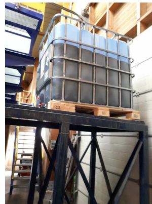
Bac de stockage de la solution autoclave
