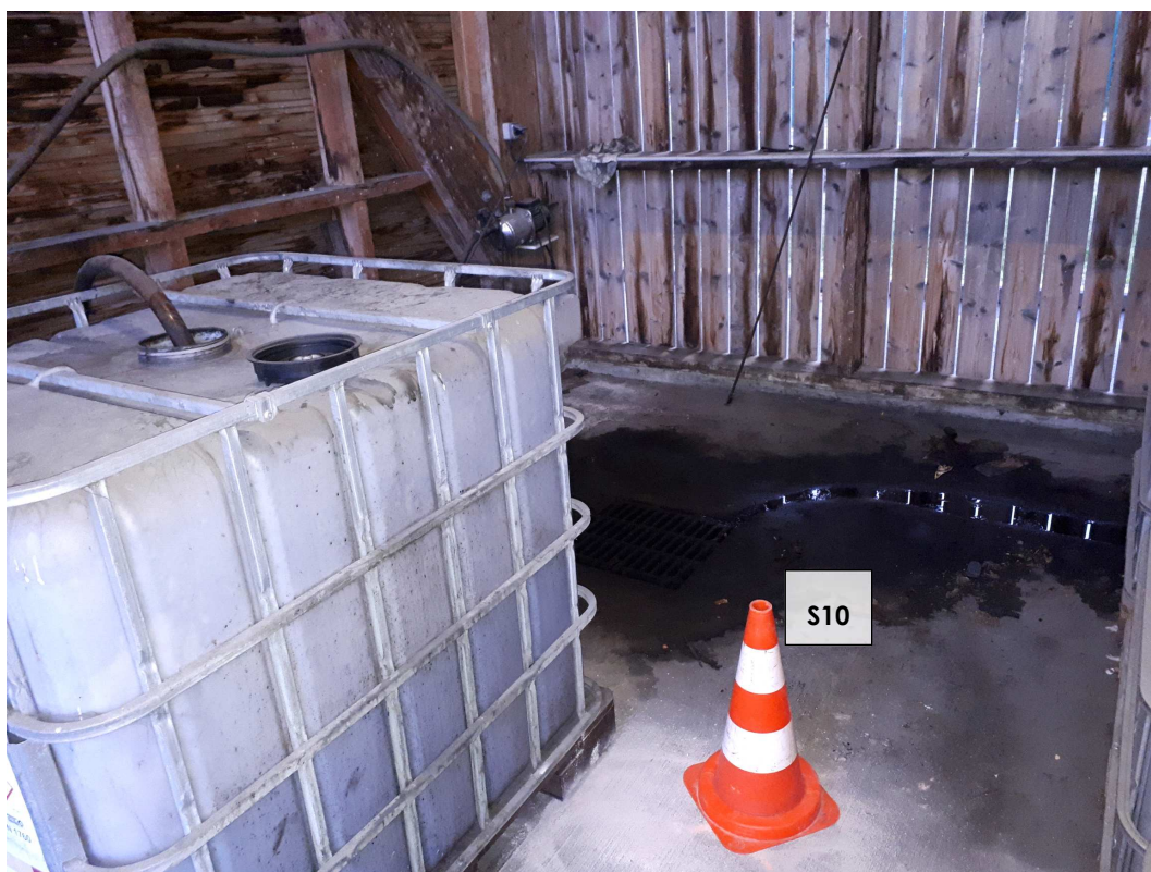
Sondage S10 (bâtiment autoclave – zone collecte des égouttures, point bas)
