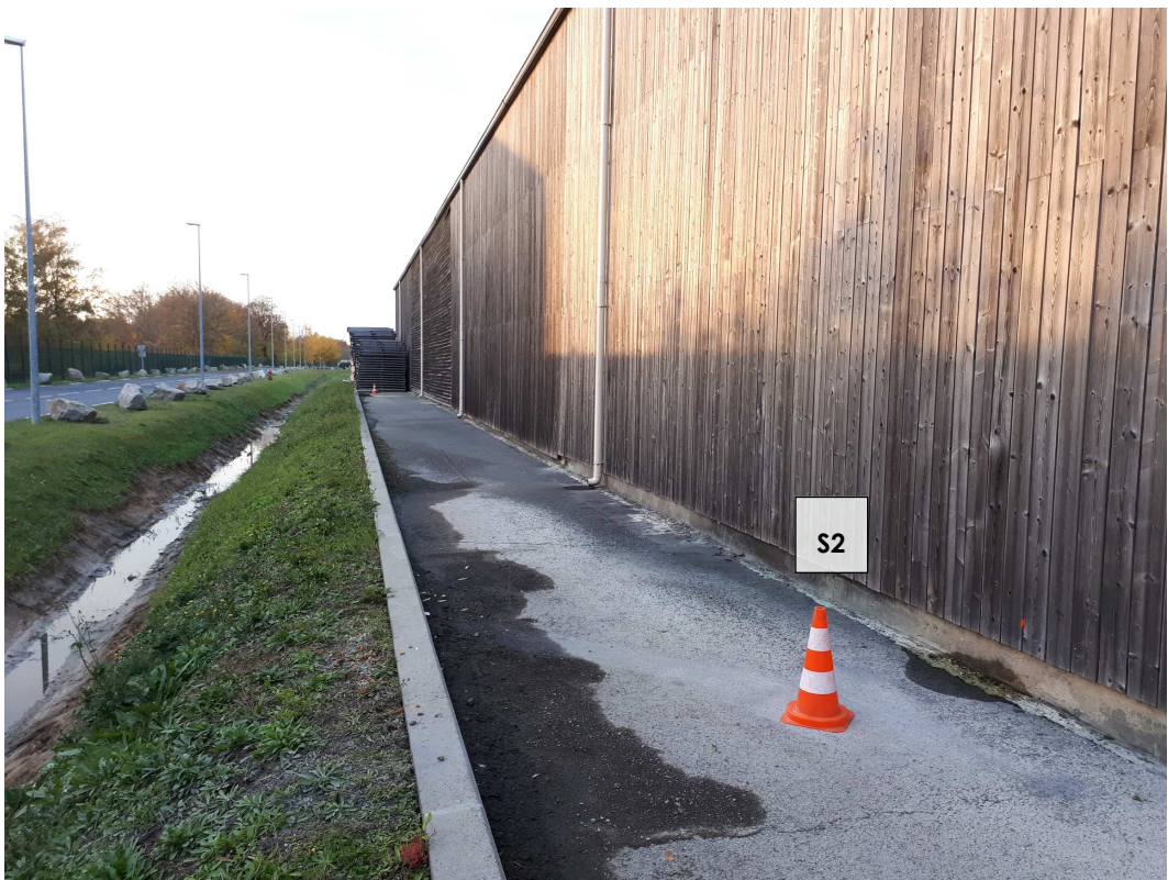
Sondage S2 (ext. bâtiment autoclave – zone collecte des égouttures)
