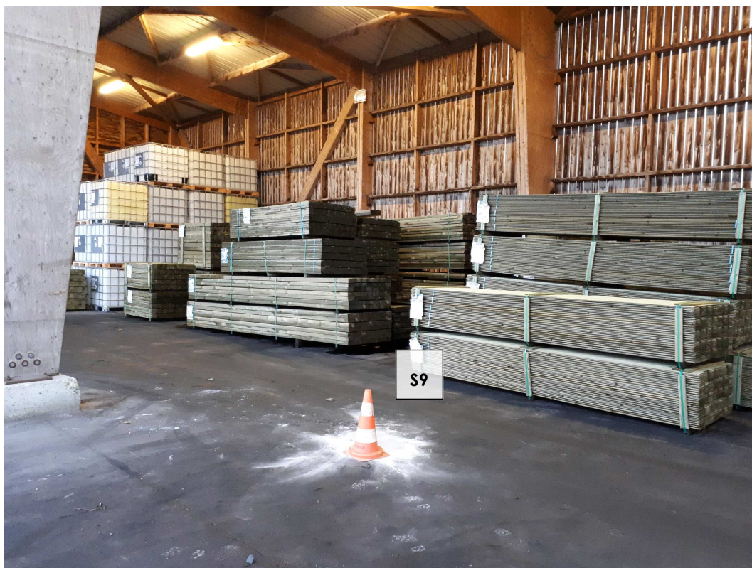
Sondage S9 (bâtiment autoclave – zone collecte des égouttures)
