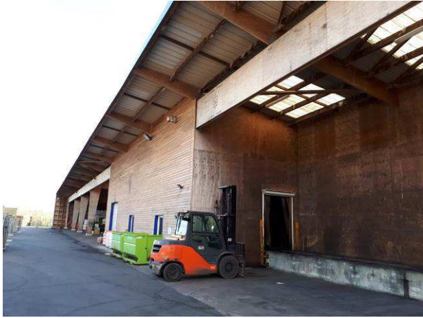
Zone de chargement
