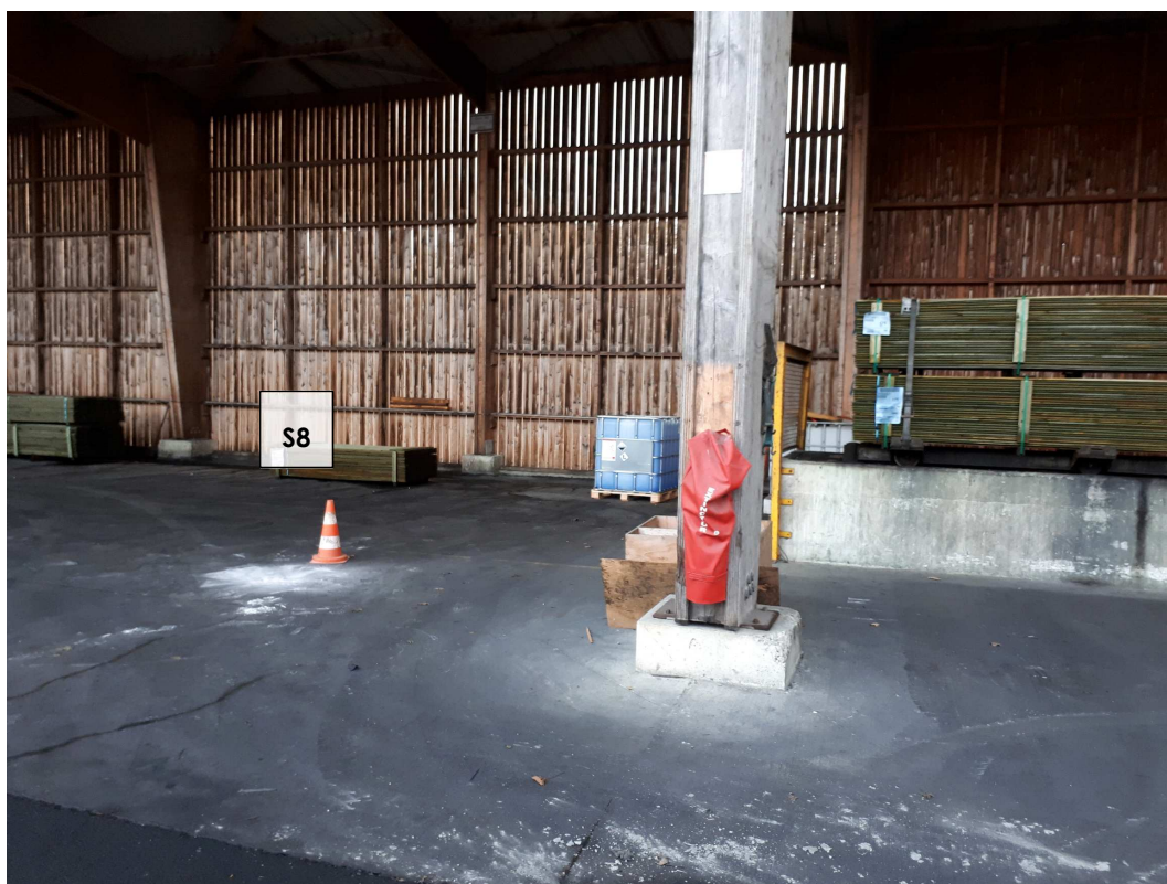
Sondage S8 (bâtiment autoclave – zone collecte des égouttures)
