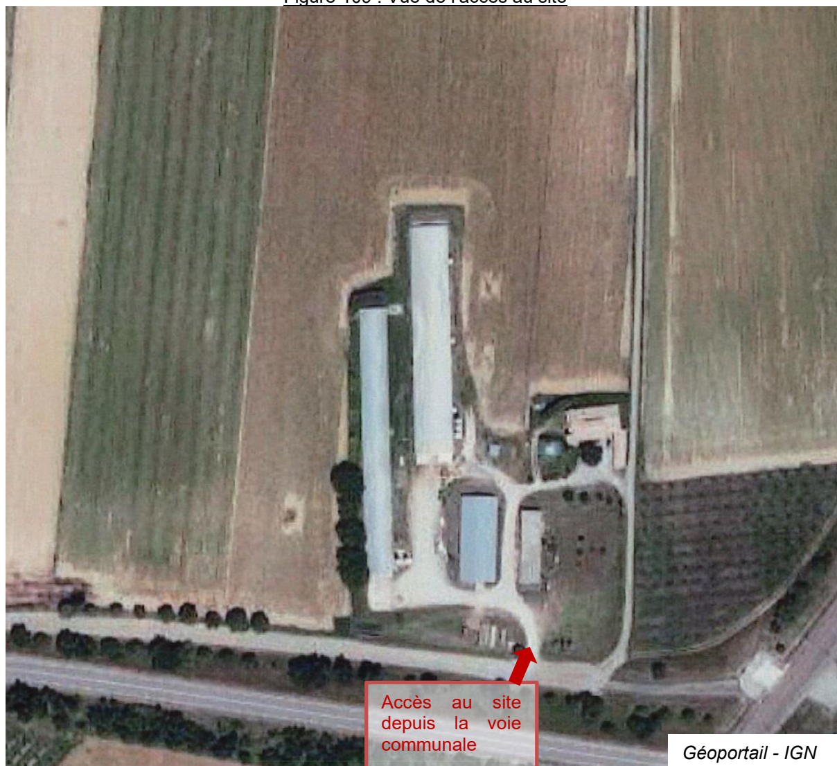
Figure 109 : Vue de l'accès au site
