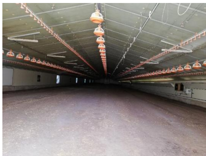
Figure 7 : Vue de l'intérieur de V2
