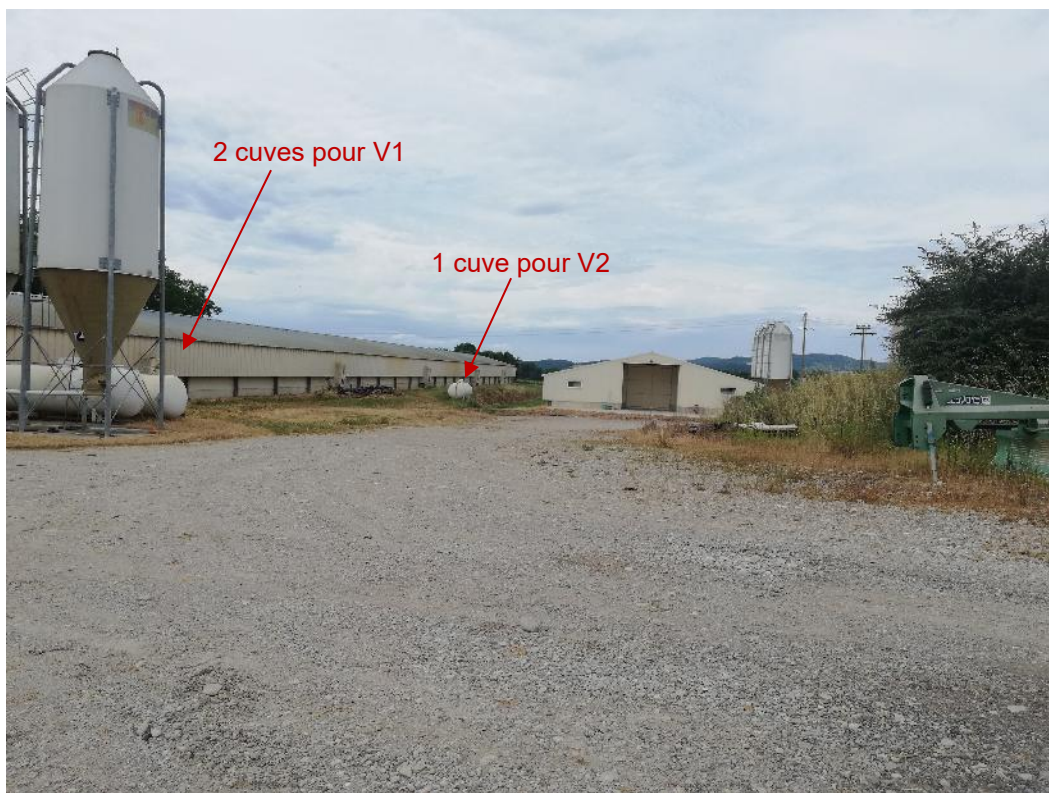
Figure 10 : Situation des cuves de gaz
