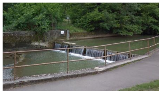
Seuil sur l'Ouche à Dijon (ROE17521).
