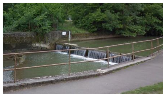
Seuil sur l'Ouche à Dijon (ROE17521).
