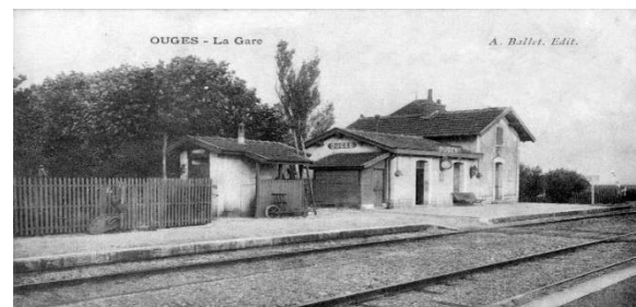
Halte ferroviaire d’Ouges, caractéristique de la maison de garde PLM, 1892
