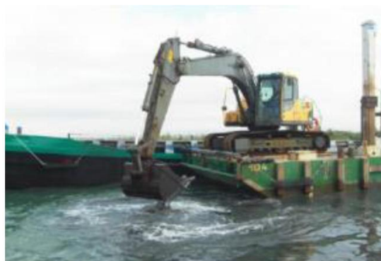
Figure 3 : Pelle sur ponton (source : dossier)
