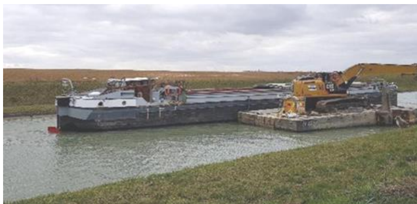
Figure 23 : Illustration d'un dragage mécanique d'une pelle sur ponton (source : VNF)
