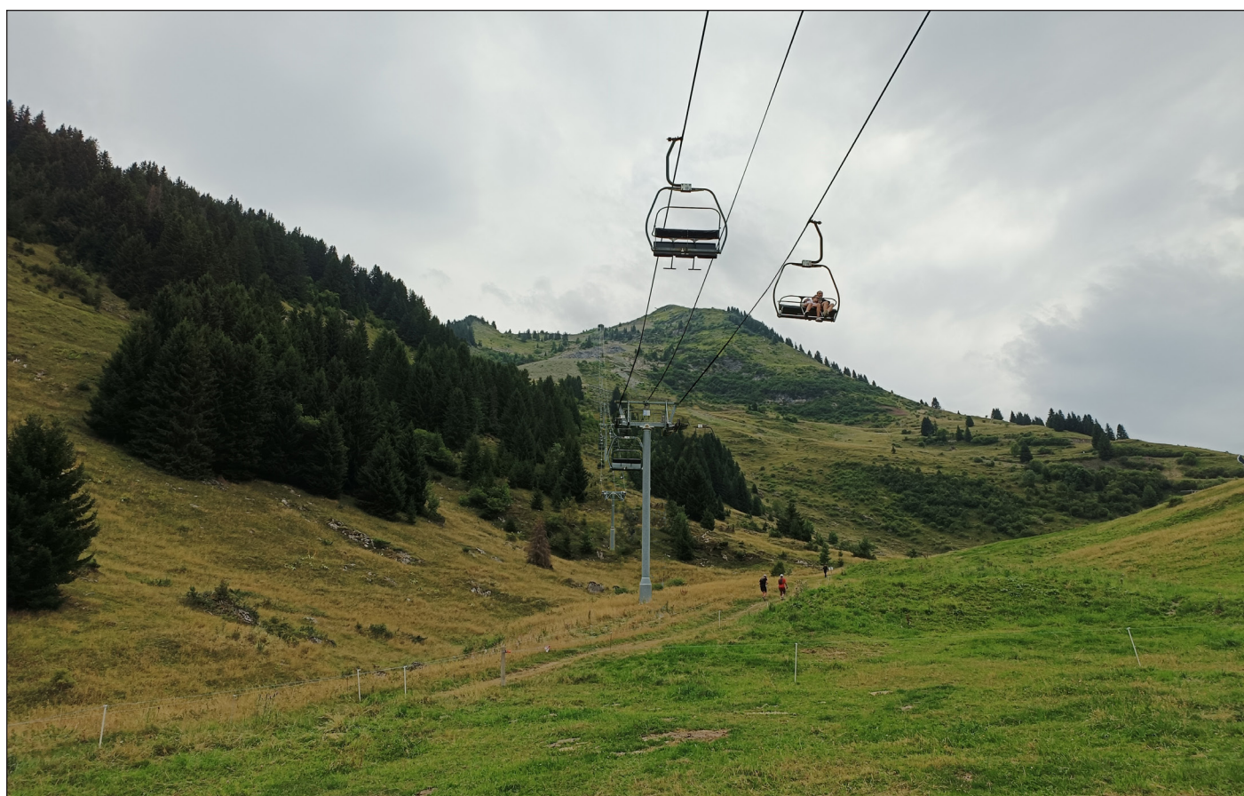
Figure 7: Vues n°06 rapprochées de la ligne - été : EXISTANT ET PROJET ; Avis Vert 2025.
