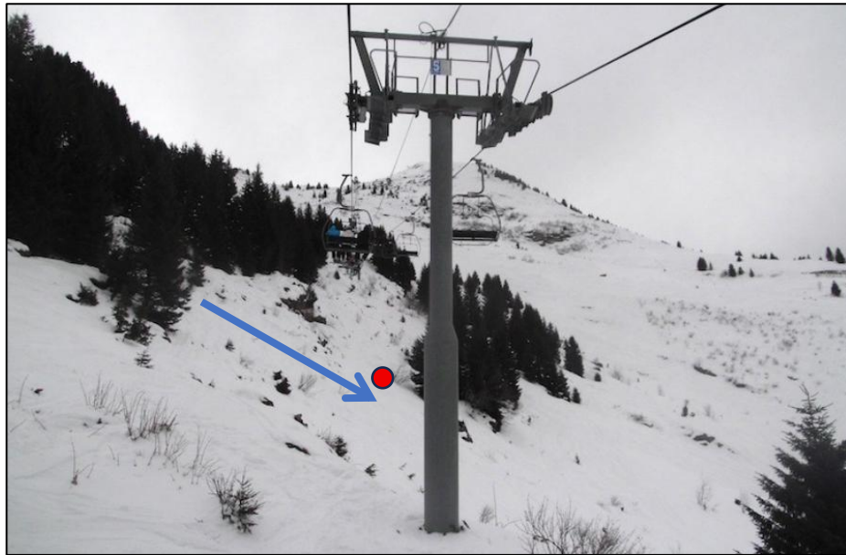
Figure 30 – Vue du P5 actuel avec emplacement (en rouge) projeté du P6 [2] par rapport au couloir latéral (flèche)
