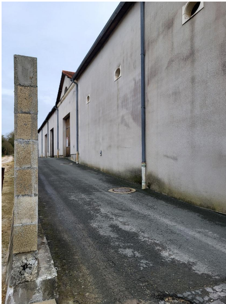
Figure 2. Mur en limite de propriété sud-ouest
