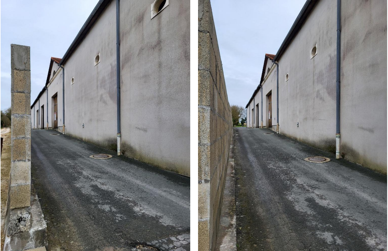
Figure 1. Photos du mur érigé entre le site (chai pineau) et les tiers
