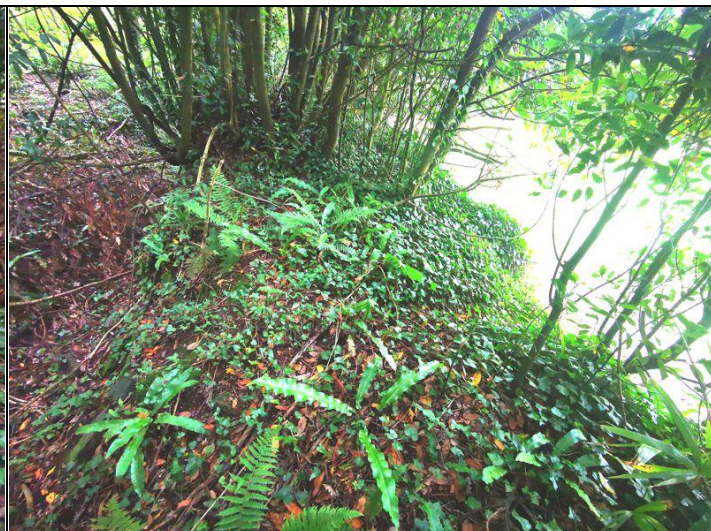
Photo 14 : Vue, du sommet du talus entre le bois parc. 2019 et parc. 1079 au nord (pelouse).
