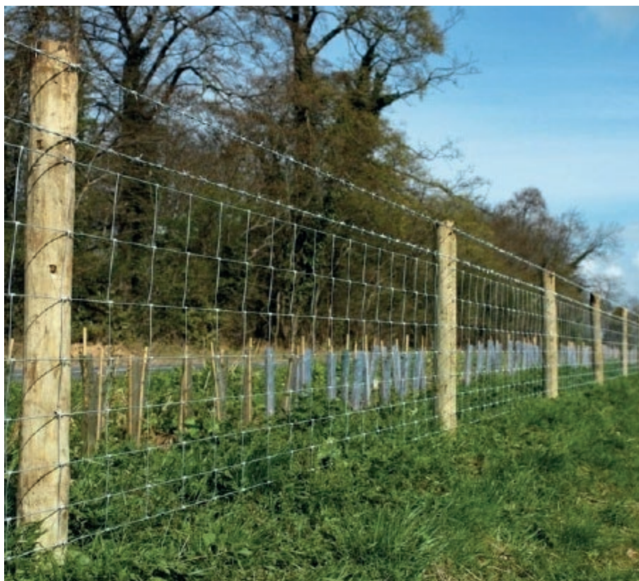
Illustration du modèle de clôture envisagé, grillage à mouton avec fils barbelé en partie haute, hauteur envisagée 1,3 m. Les poteaux au lieu d'être fixés au béton, sont simplement enfoncés dans le sol support.
