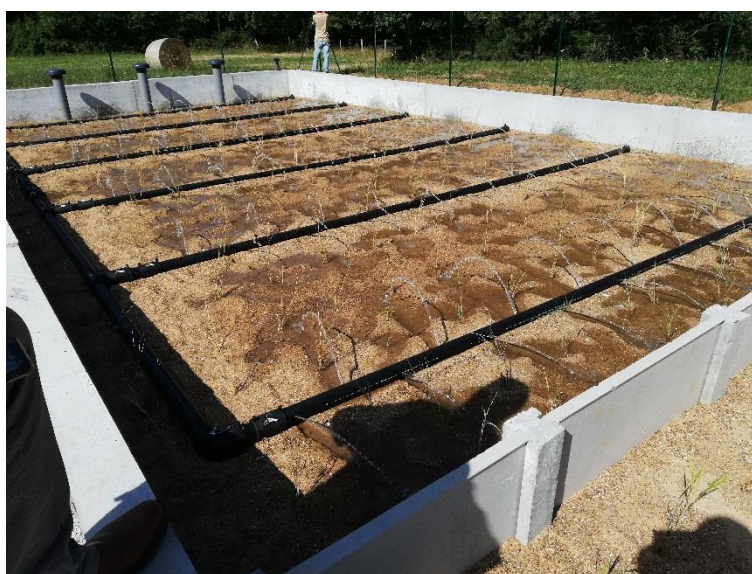
Figure 47 : Exemple d'un deuxième étage (mise en service)
