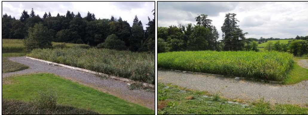
Figure 41 : Exemple de procédés de type filtres plantés de roseaux
