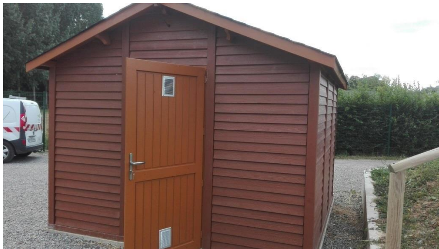
Figure 48 : Exemple de local technique de type chalet en bois (STEP Bouère – 53)
