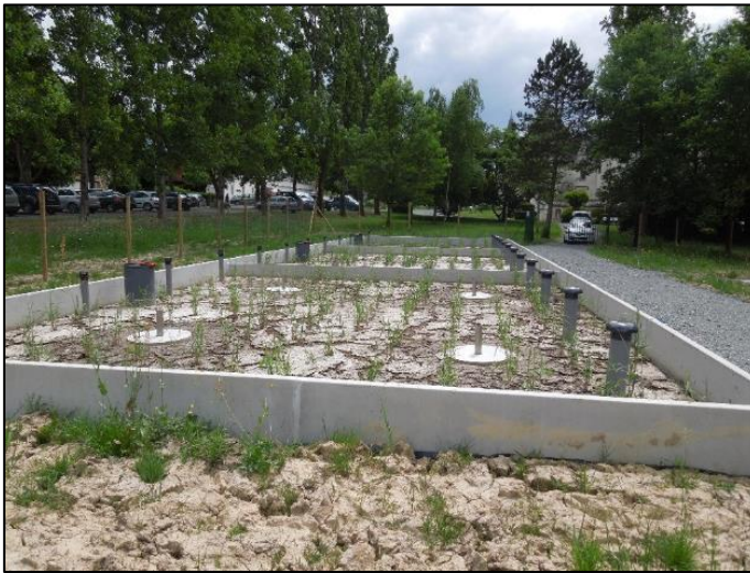
Figure 44 : Exemple d'un premier étage de filtration (jeunes pousses) et regard de mise en charge
